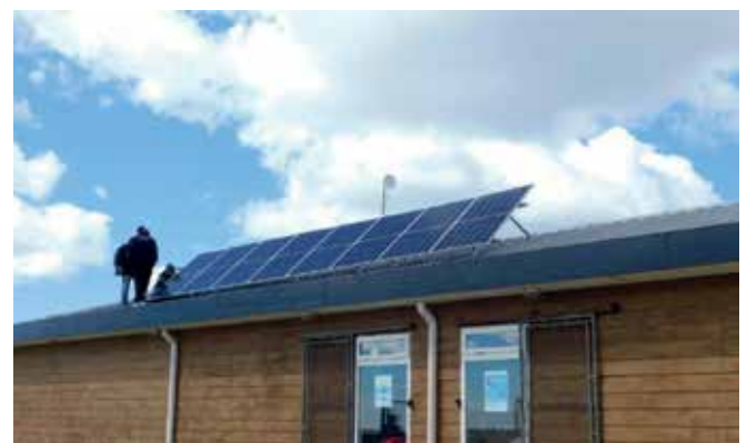
Instalación de paneles fotovoltaicos en el Centro de Interpretación Ambiental de Río Grande
