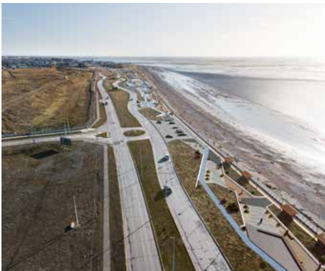
Nuevo muro costanero
