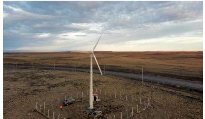
Turbina eólica Cabo Domingo - Río Grande
